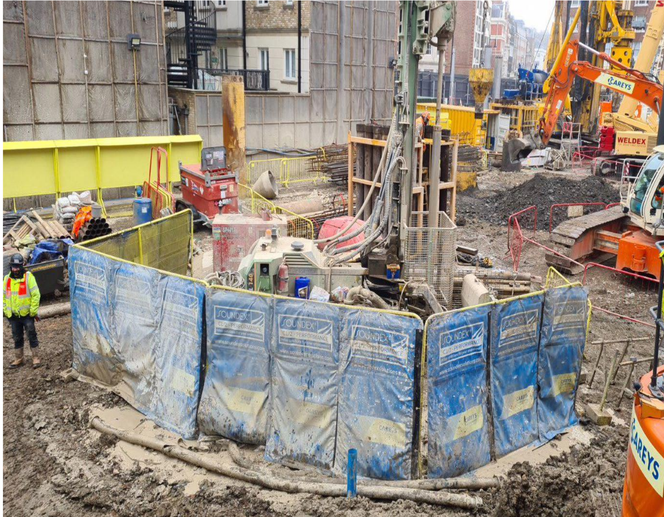
GSHP –Ground Source Heat Pump Mini Rig Drilling
