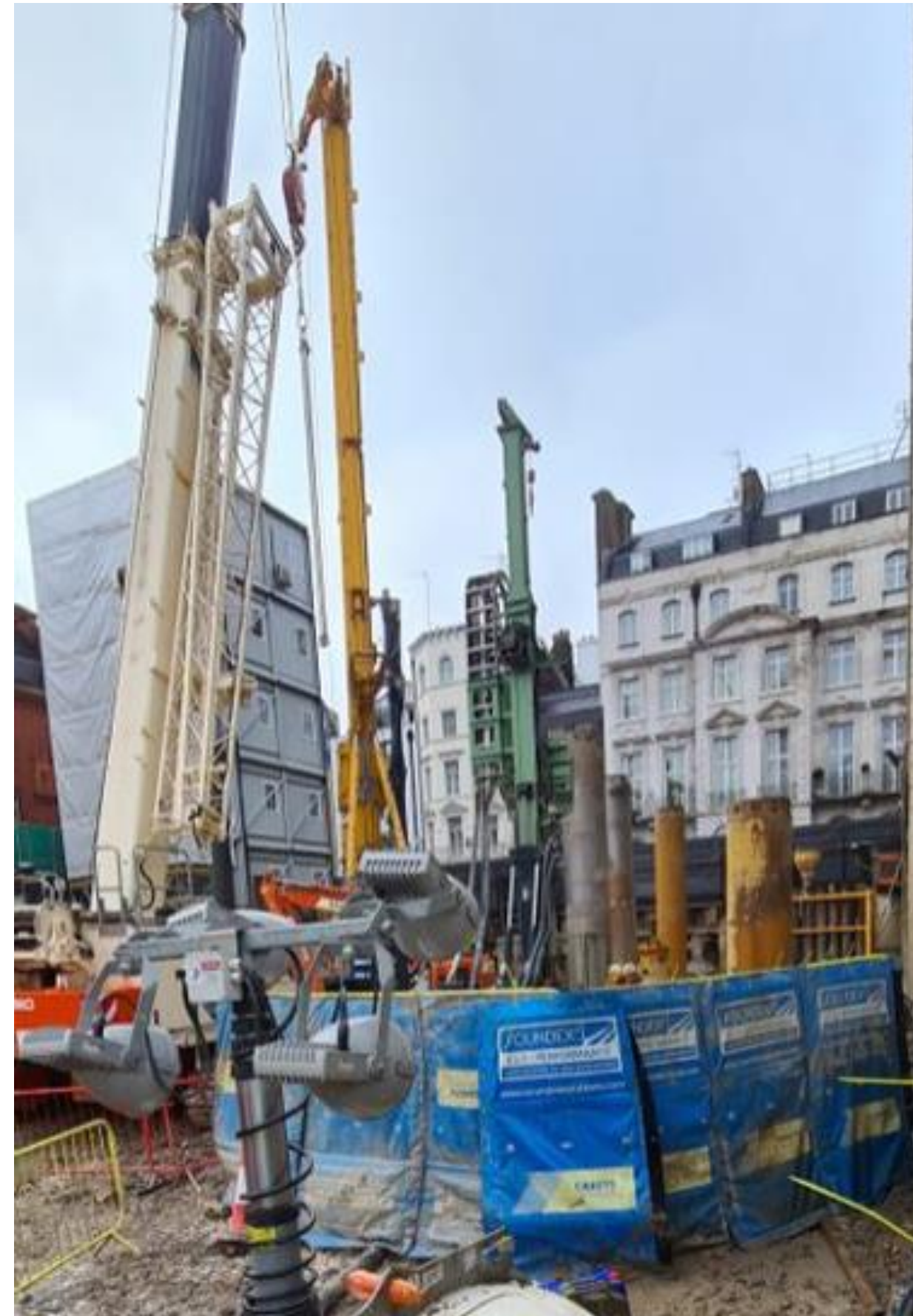
GSHP –Ground Source Heat Pump Mini Rig Drilling
